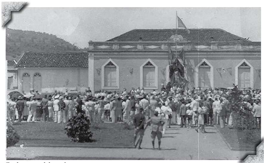
Prédio original da prefeitura
